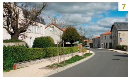
7. Réfection de la voirie et des abords, paysagement en sortie de bourg sur la route de Saint-Michel-Mont-Mercure
